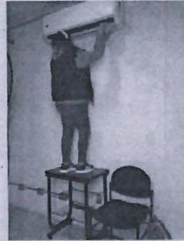
Se realizó limpieza en aire acondicionado
