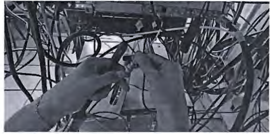
Cambio de conector "BNC"
