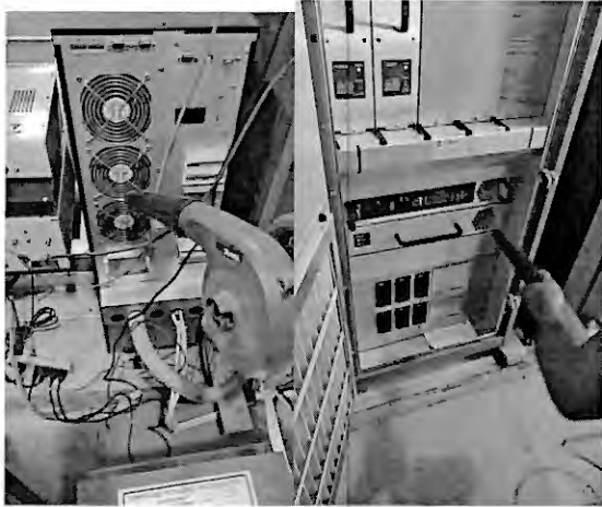
Limpeza de UPS y del transmisor de FM
