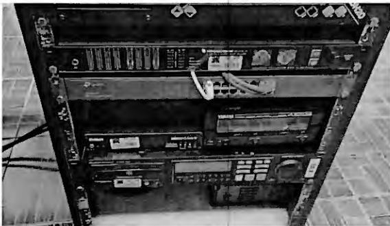
Limpeza de los equipos de cabina de transmisión en el rack
