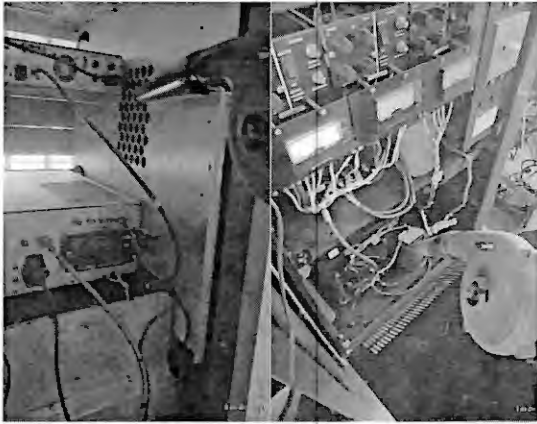
Limpeza del transmisor de FM y del regulador de voltaje
